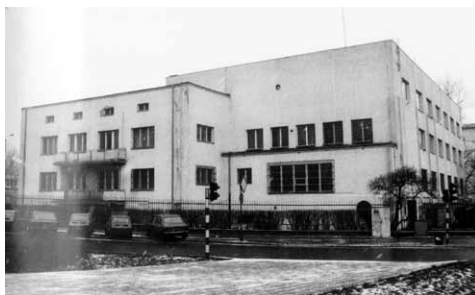
Fot. 6. Budynek, który był siedzibą ekspozytury bydgoskiej w latach 1937–1939 z adresem Al. Powstańców Wielkopolskich 5. Stan z lat osiemdziesiątych XX w., obecnie wygląda inaczej, po daleko idącej przebudowie.
