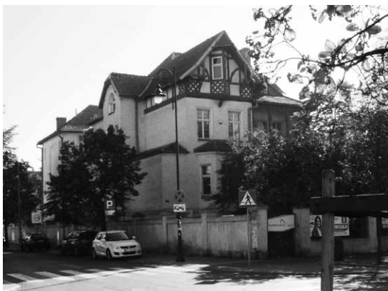
Fot. 3. Willa przy ul. Gdańskiej 84, stan obecny, widok od ul. Gdańskiej w kierunku ul. Zamoyskiego. W latach 1931–1937 siedziba Ekspozytury nr 3 Oddziału II w Bydgoszczy. Źródło: zdjęcie autora z 2018 r.
