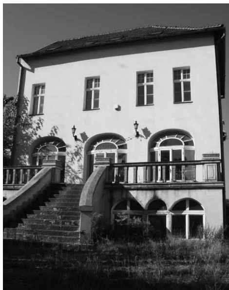
Fot. 4. Willa przy ul. Gdańskiej 84, widok od ogrodu, stan obecny. Źródło: zdjęcie autora z 2018 r.
