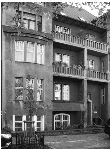
Fot. 8. Fragment kamienicy przy ul. 20 Stycznia 1920 roku nr 10.
