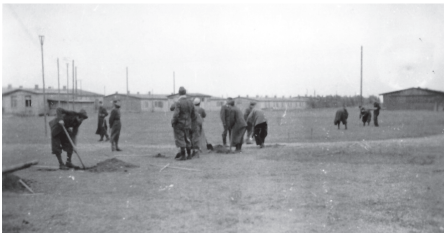
Zdjęcie 1. Italiener beim Pfosteneinsetzen für den Stacheldraht (Włosi przy osadzaniu słupów do drutu kolczastego). Włosi pracujący w Stalagu I F Sudauen – budowa Sonderlager Ost Sudauen (obozu przeznaczonego dla sowieckich lotników) (Suwałki, jesień 1943 r.)
