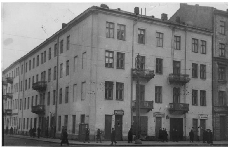
Ryc. 2. Narożna kamienica pod adresem Bonifraterska 10 / Sapieżyńska 23. Prawdopodobnie w bramie widocznej przy lewej krawędzi zdjęcia żołnierze „Chwackiego” montowali minę
