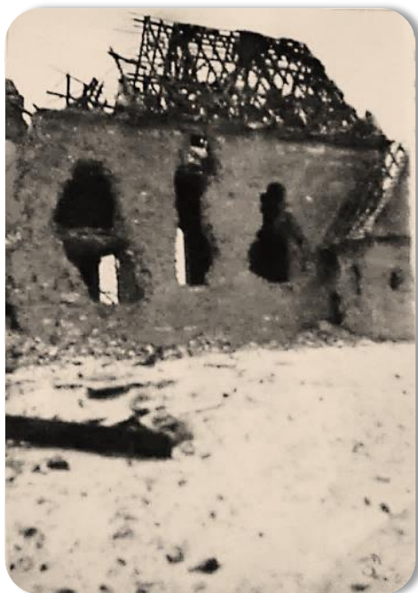
Kargów, kościół pw. św. Władysława, widok od strony południowo-wschodniej (ADK, Szkody wojenne 1944–1945, k. 85)
