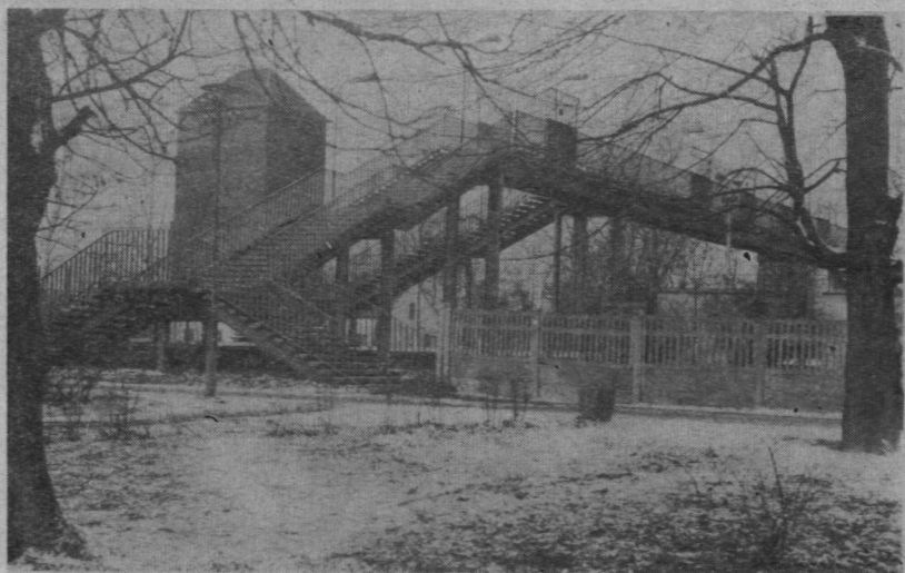
Kładka nad torami kolejowymi w rejonie dworca PKP z dojsciami na perony — łącząca części miasta podzielone torami. Foto nr 10
