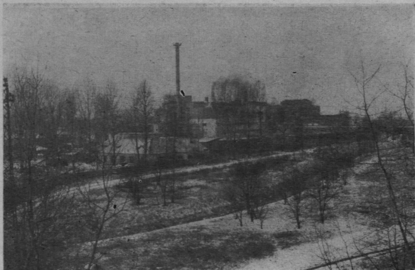
Widok na „starą” ciepłownię Pruszków I od strony wiaduktu. Przeprowadzona w niej modernizacja zabezpiecza energię ciepłą do czasu wybudowania ciepłowni Pruszków II w Mosznie. Foto nr 6
