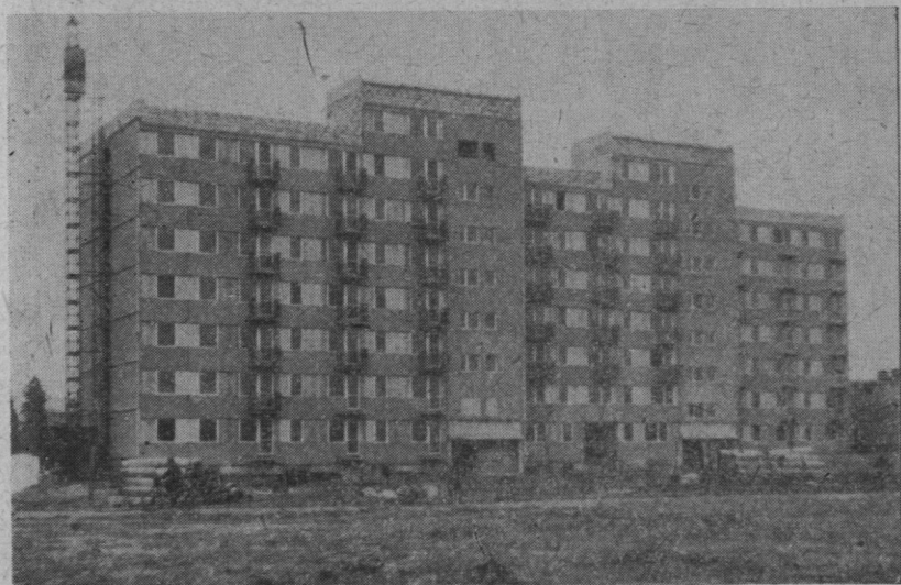
Budynek o 118 mieszkaniach dla emerytów, rencistów i osób niepełnosprawnych przy ul. Księcia Józefa — w budowie.
