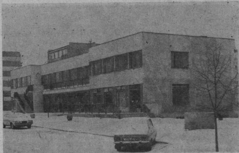
Sklepy: spożywczy, mięsny, chemiczny w parterze budynku przy ul. Andrzeja. Osiedle Wyględówek
