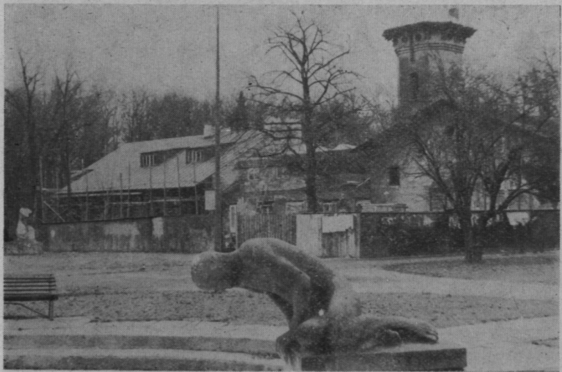
Na zdjęciu zabytkowe budynki, w których będzie się mieścić Muzeum Starożytnego Hutnictwa. Trwające od wielu lat prace adaptacyjno — konserwatorskie odwołują moment otwarcia tej ze wszechmiar potrzebnej placówki.
