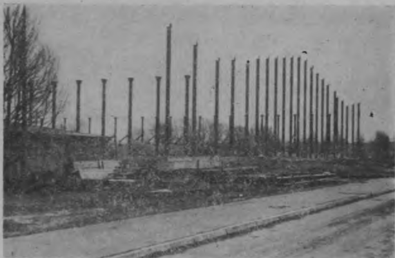
Teren Ośrodka Sportu i Rekreacji w Pruszkowie. Widoczne na zdjęciu słupy, to żelazna konstrukcja na której będzie umocowane zadaszenie sztucznego lodowiska.
