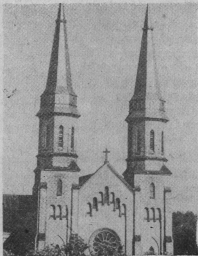
Współczesny widok pruszkowskiej świątyni z nowymi hełmami na wyniosłych wieżycach.
