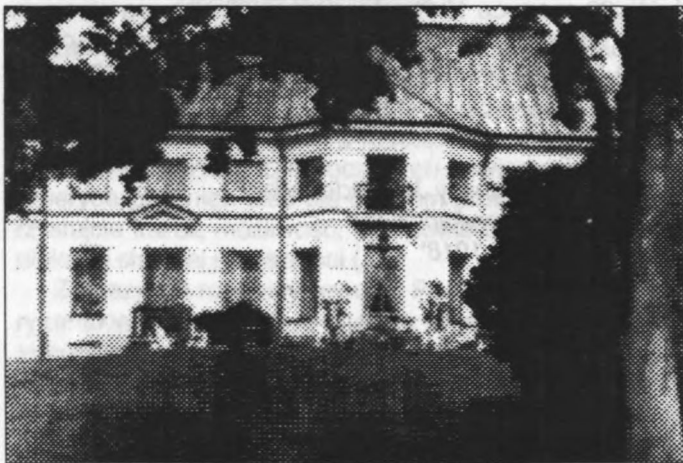
Pęcice. Elewacja ogrodowa dworu - czerwiec 1993
