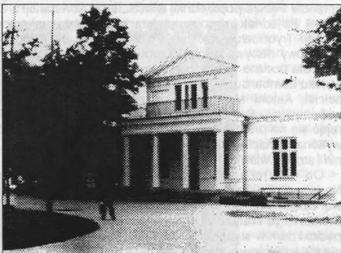
Pruszków. Elewacja frontowa pałacyku - czerwiec 1993
