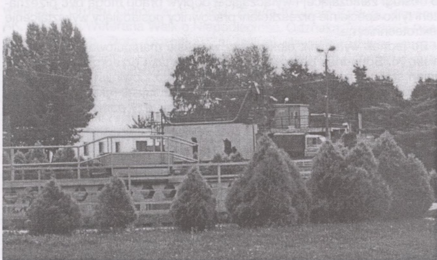
Oczyszczalnia ścieków w Pruszkowie. Widok na osadnik wstępny i piaskownik
