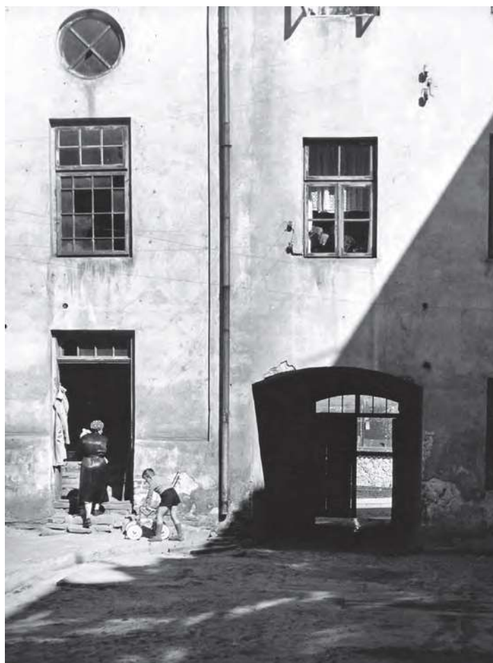
Oficina na Lubelskiej 8 – oficina od strony ul. Krzywej, stan przed zawaleniem się w latach 70.
