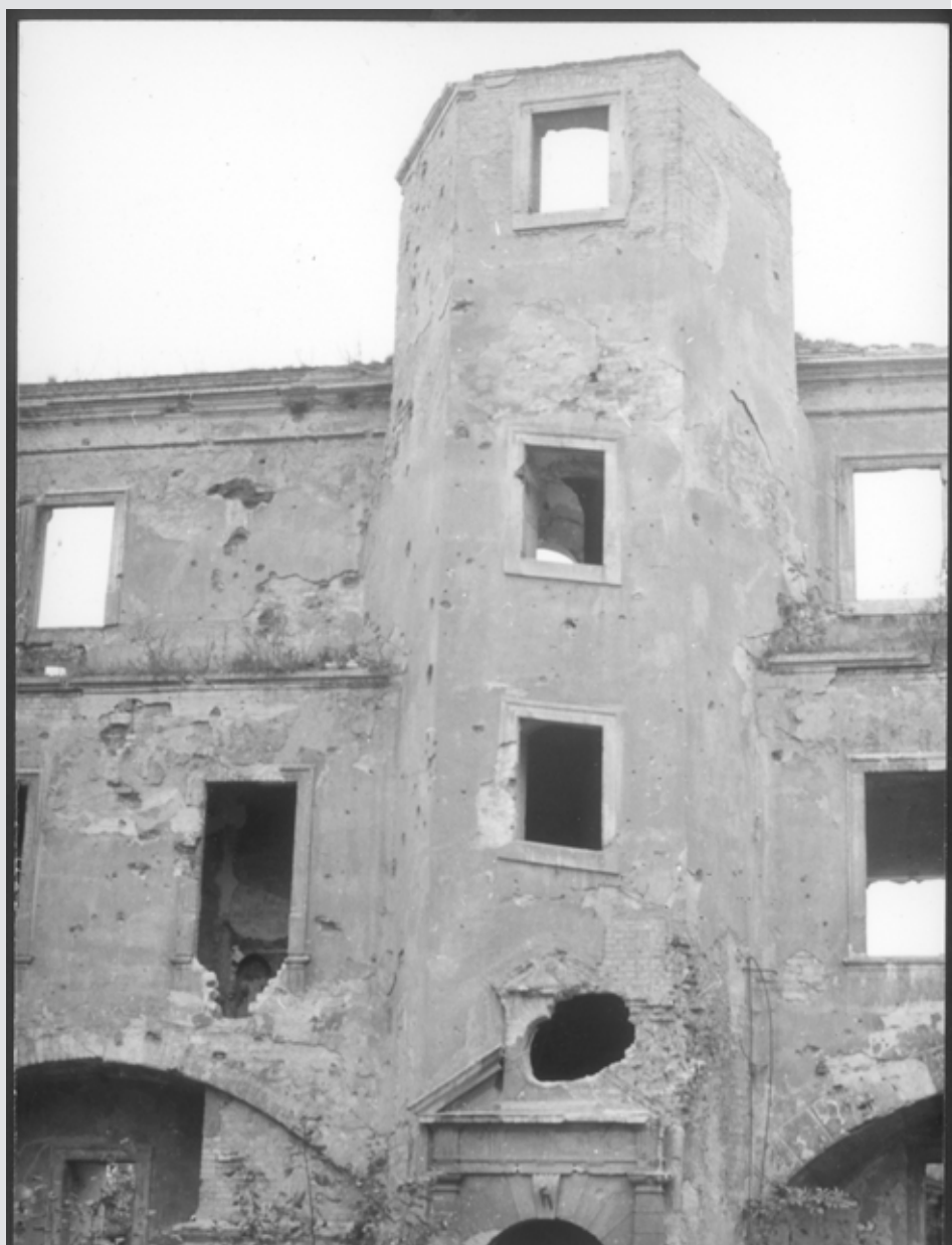
Ryc. 10 Skrzydło zamku od strony Odry, tzw. wieża trójboczna
