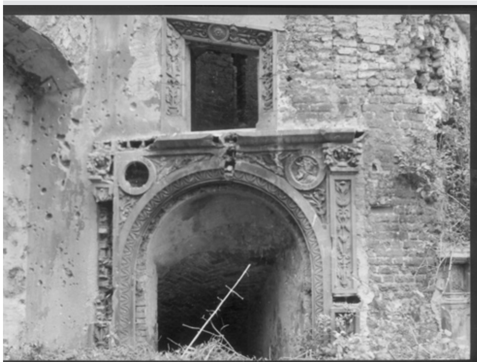
Ryc. 7 Terakotowy tzw. portal piwniczny zamku kostrzyńskiego
