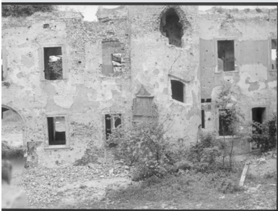
Ryc. 11 Skrzydło wejściowe zamku od strony dziedzińca; widoczna brama wjazdowa i wieża z portalem terakotowym
