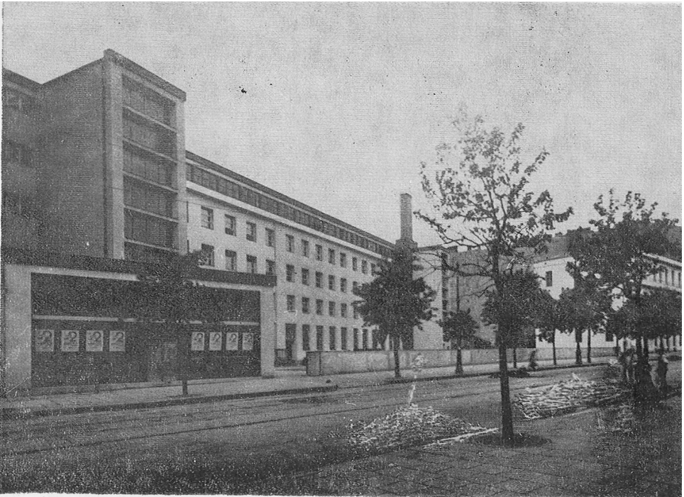
Kompleks budynków koncernu Dom Prasy S.A. przy ul. Marszałkowskiej 3/5/7, łącznie z budynkiem widocznym na prawo za drzewami. Na lewo wejście główne do portierni i hallu, za niskim murem, na pierwszym planie, parking samochodowy i rowerowy. Tutaj, bezpośrednio z ekspedycji przy maszynach rotacyjnych na parterze, odbierali kolporterzy egzemplarze gazet.
