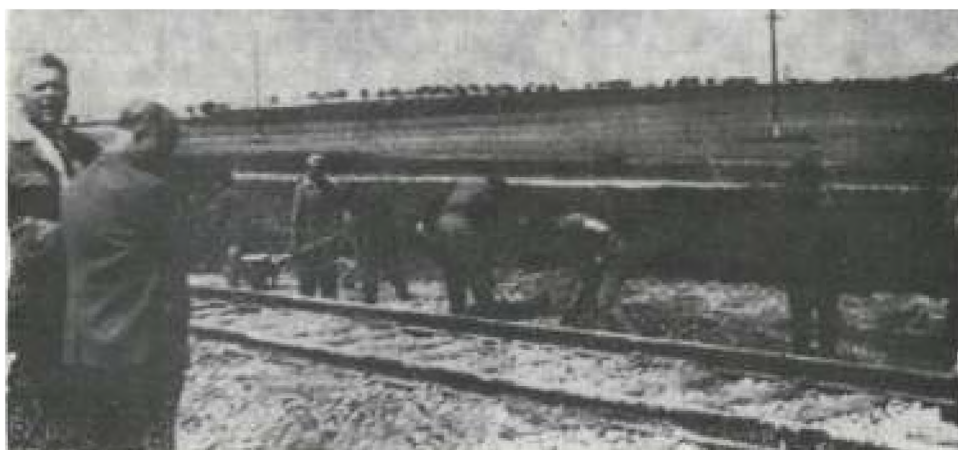
16. Budowa torów kolejowych koło Kolbuszowej (na zdjęciu inż. M. Hrycyszyn z prawej i W. Opaliński z lewej).
