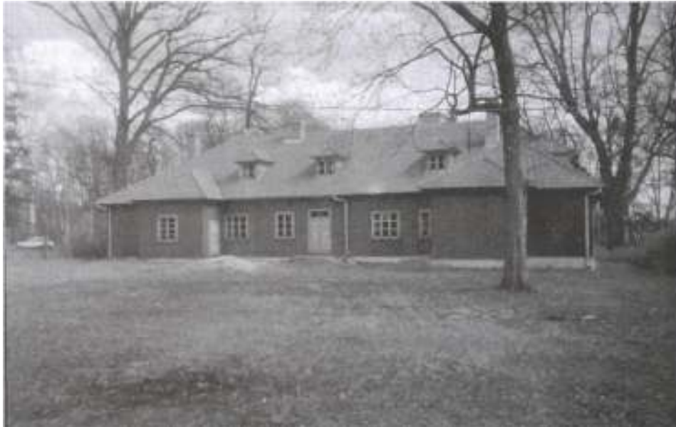
Elewacja północno- zachodnia dworku.
