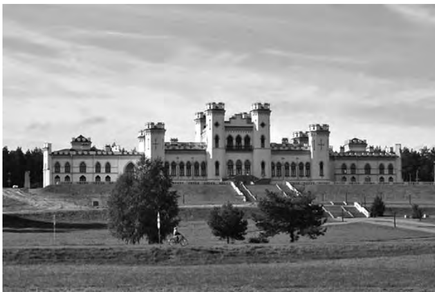
Pałac Pusłowskich w Mereczowszczyźnie, spalony przez partyzantów radzieckich w 1942 r., po odbudowie, 23 września 2019 r.
