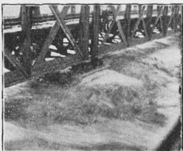
Ryc. 5. Most kolejowy na Dunajcu w Bogumiłowicach w czasie kulminacji fali powodnej.
