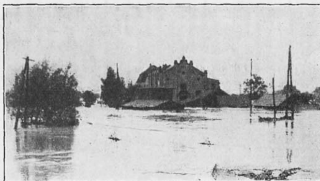
Ryc. 4. Zatopiona elektrownia w N. Sączu.
