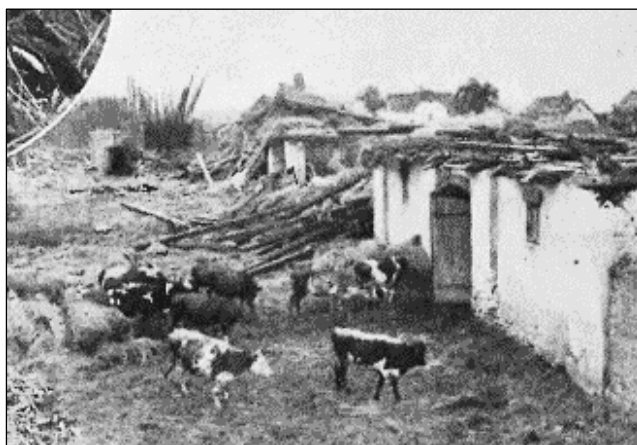
Ryc. 4. Zniszczenia na folwarku Tatarów
