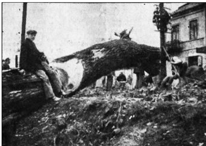
Ryc. 2. Uszkodzenia budynków spowodowane drzewami połamanymi przez huragan
