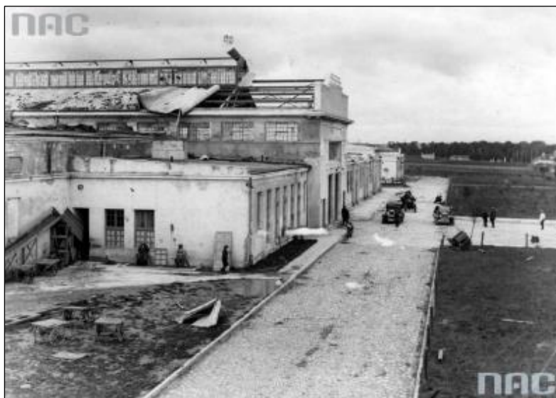
Ryc. 6. Zerwany dach nad rzeźnią miejską
