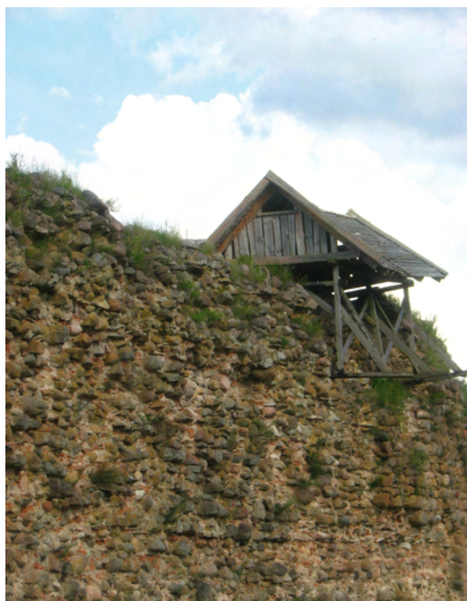
Fot. 3-6 (fot. 5-6 na nast. stronie). Ruiny murów obwodowych i wież zamku Olgerda i Jagiełły w Krewie. Fot. Aliaksandr Kazakou.
