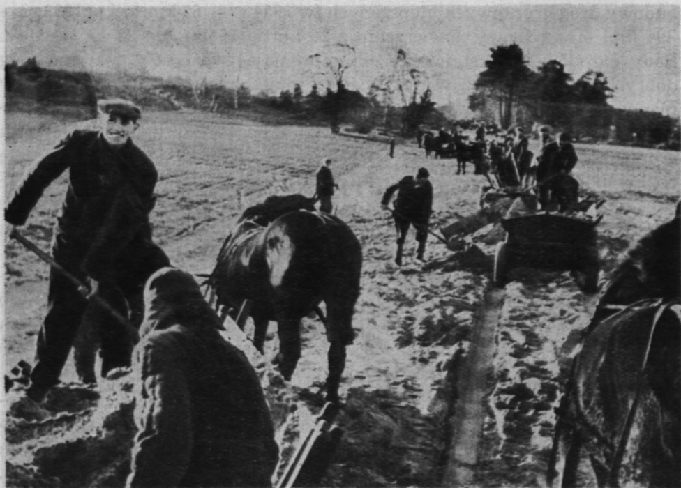
16. Rolnicy z Cierpiąt (pow. przasnyski) przy budowie drogi w czynie społecznym
