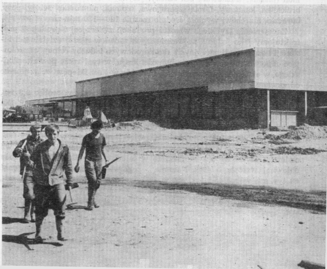
Ryc. 1. Budowa chłodni-zamrażalni owoców i warzyw w Płońsku, wykonywana przez PBP „Petrobudowa” z Płocka
