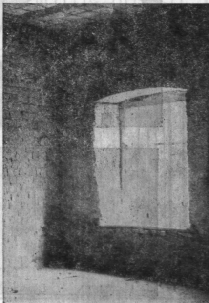
Wąskie okno strzelnicze w południowej ścianie Wieży Zegarowej zamku płockiego. Fot. Wiesław Dyśkiewicz.
