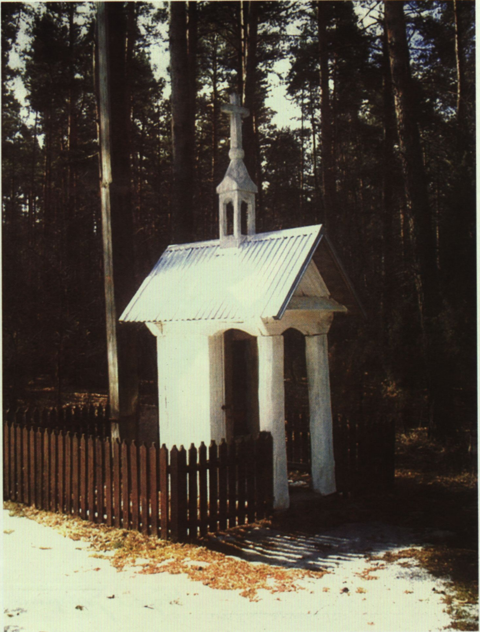
8. Kapliczka w Broku przy drodze do Bojan
