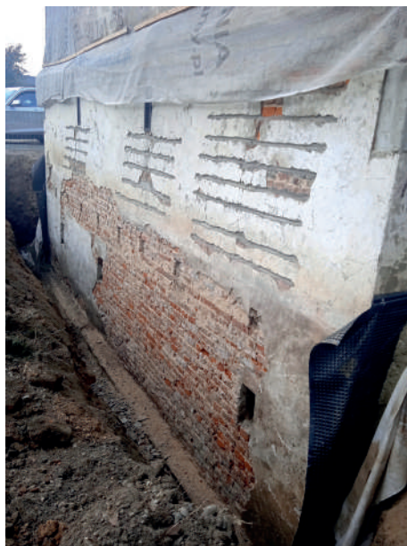
Ryc. 5. Odslonięta ściana południowa spichlerza w Raciborzu-Sudole z widocznymi oknami piwnicznymi, 2021 rok Fot. Cezariusz Magott
