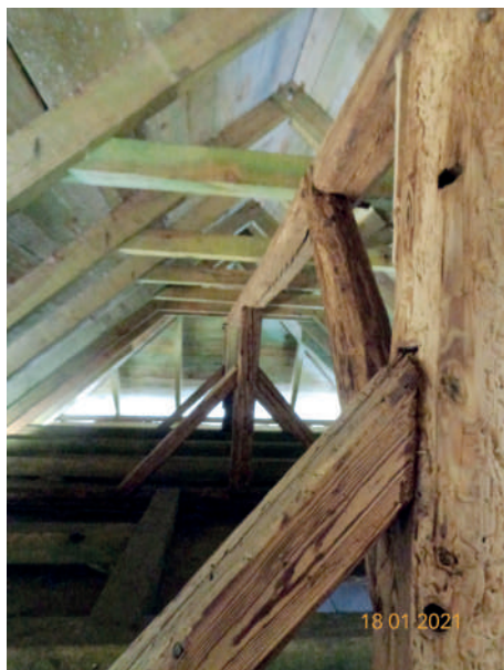
Ryc. 3. Nowa więźba dachu spichlerza w Raciborzu-Sudole z zachowanym oryginalnym elementem, 2021 rok Fot. Maria Olejarnik
