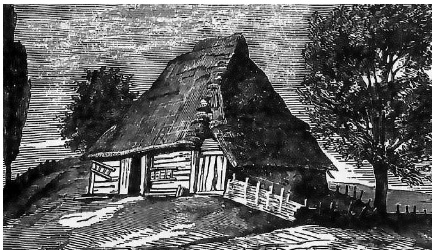
Ryc. 2. Stodoła z podkrakowskiej wsi zbudowana w konstrukcji sochowej Źródło: O. Kolberg, Dzieła wszystkie , t. 5: Krakowskie , cz. 1..., s. 157
