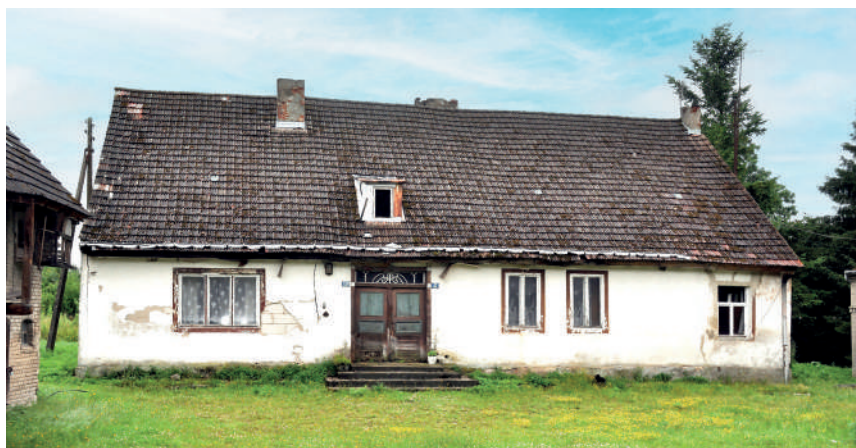
Ryc. 22. Dziadowo 12–12A, chałupa w zagrodzie czworobocznej, widok z zewnątrz, stan na lipiec 2024 roku Fot. Agnieszka Słowińska
