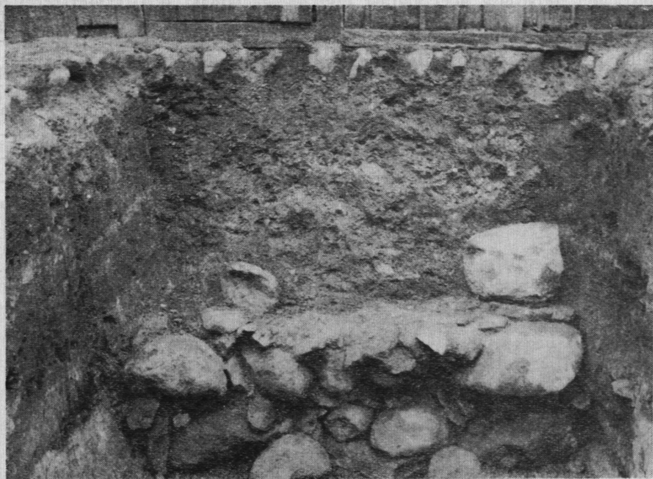
Ryc. 12. Struktura fundamentu płockiego palatium Chrobrego ułożonego z warstw dużych głazów polnych wyrównywanych tłuczniem i zalewanych skąpo zaprawą murarską
