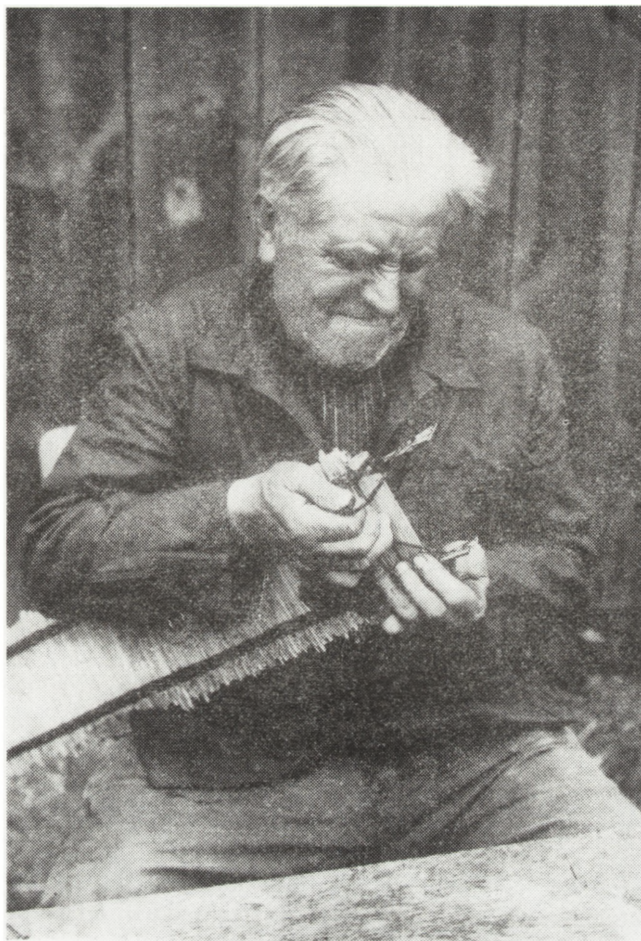
Ryc. 14. Zaciąganie dratwy po założeniu słupka. Podmachoci-ce
