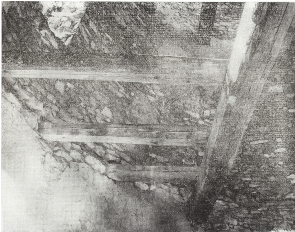
Rys. 4. Fragmenty konstrukcji stropu I piętra
