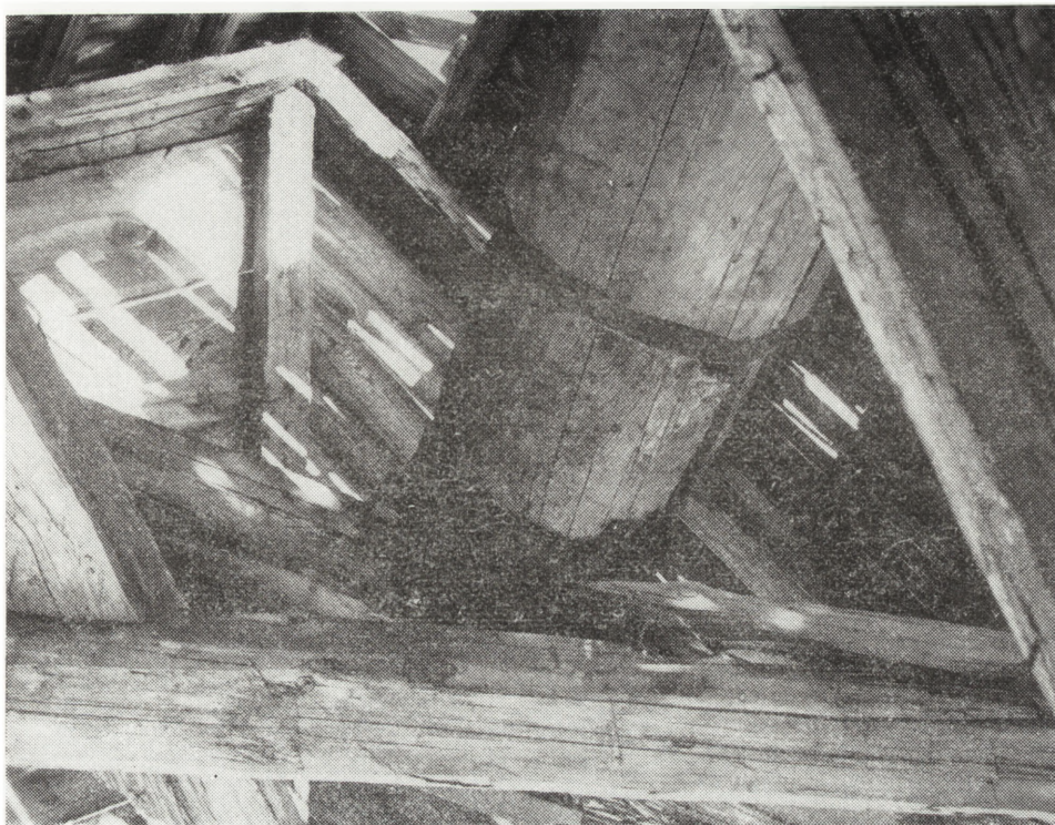
Rys. 5. Drugie piętro — zaczopowanie tylnego końca wału skrzydłowego
