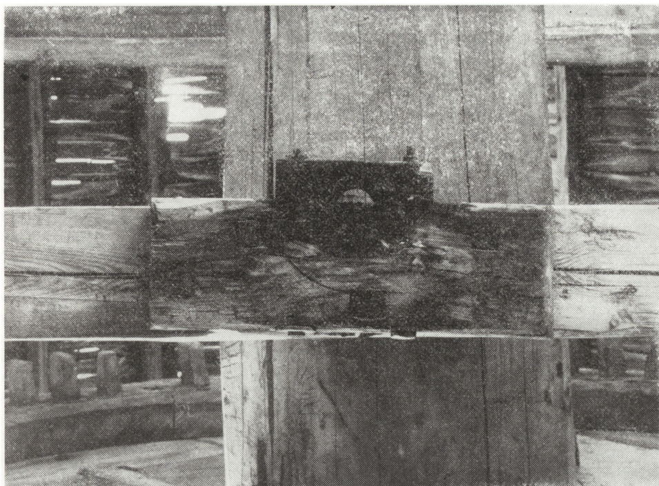
Ryc. 7. Ślady po osadzeniu wału sztorcowego
