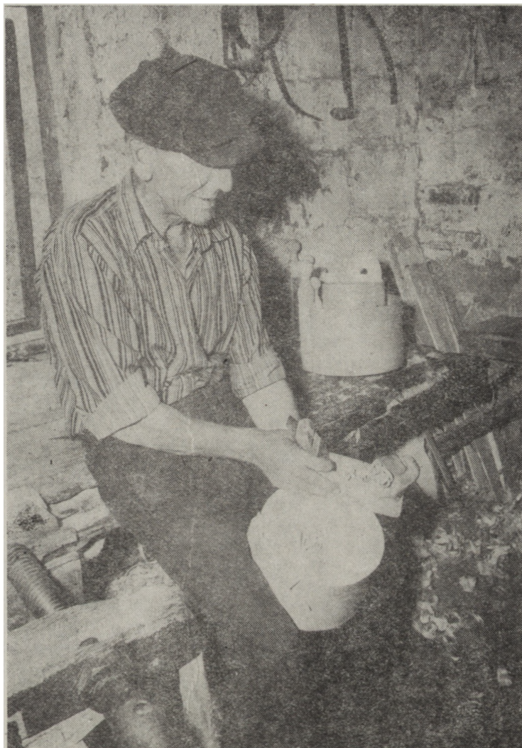
Ryc. 11 Wyrównywanie heblem kra- wędzi miarki wo- kół dna
