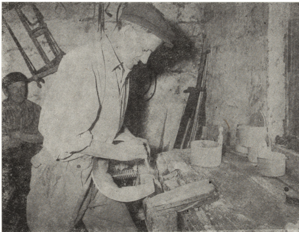
Ryc. 7. Końcowa faza gięcia obłąka na miarkę
