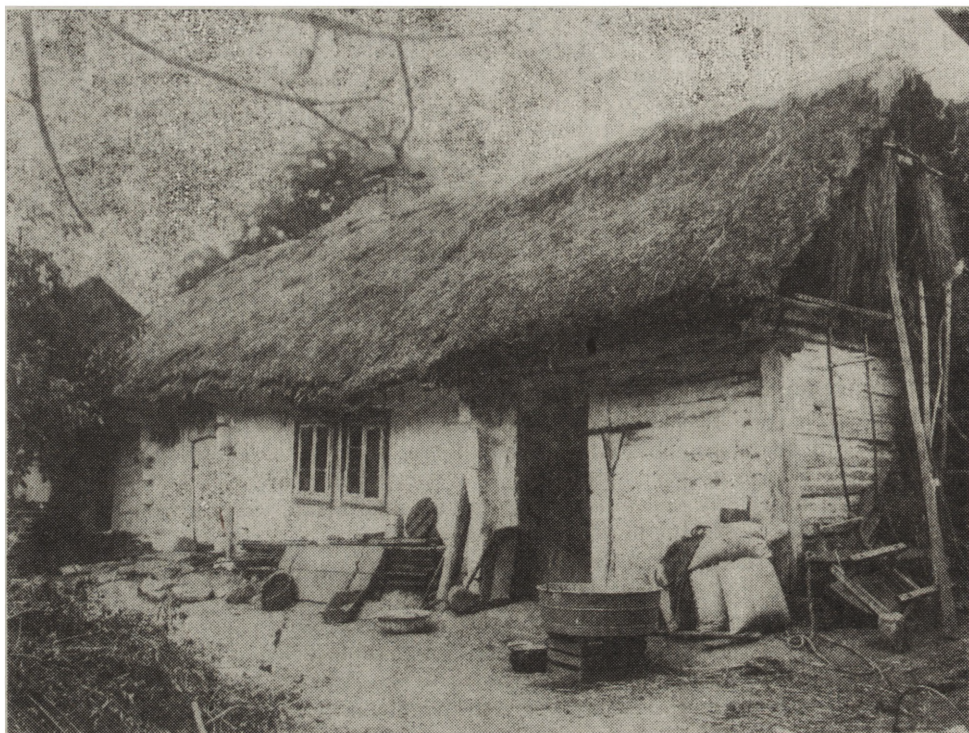
Ryc. 4. Chałupa 39. Elewacja południowa
