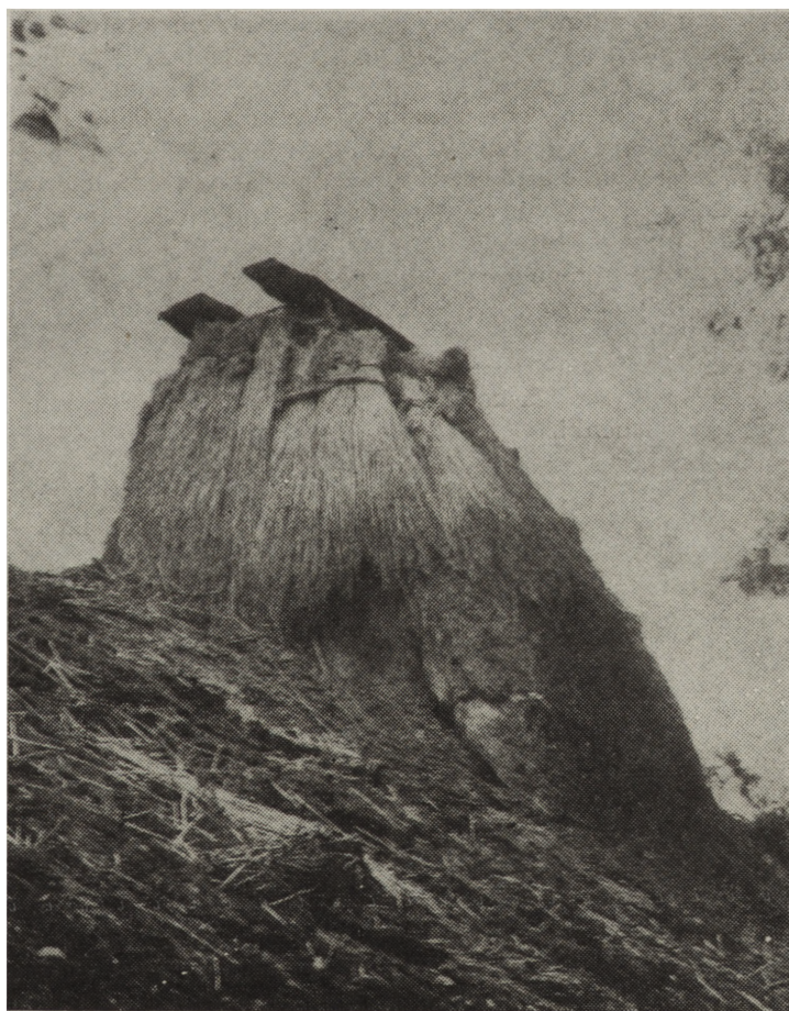
Ryc. 5. Górna część sztagowego komi- na
