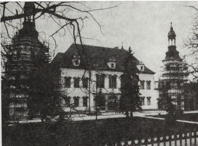
Ryc. 6. Fasada korpusu głównego pałacu, stan z przełomu 1983 i 1984 r.
