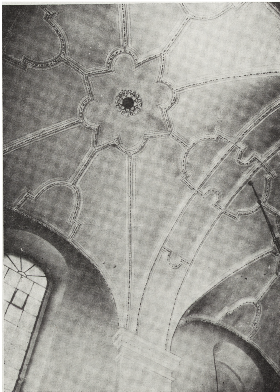
Ryc. 3. Kościół Św. Trójcy w Kielcach, dekoracja sklepienia nawy
