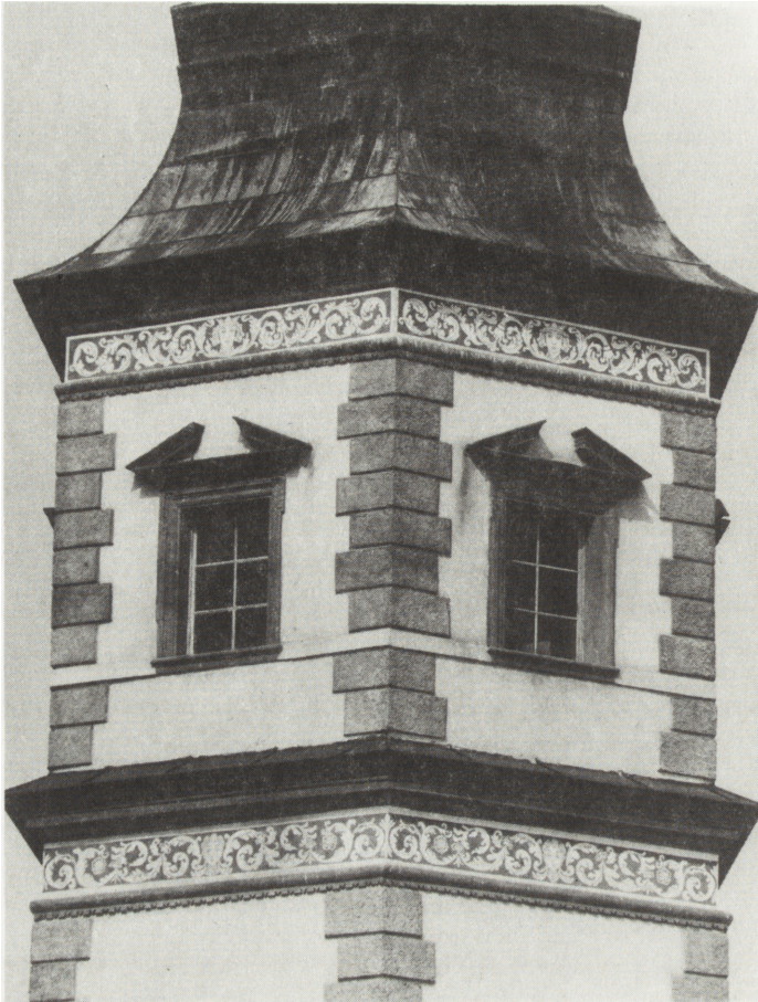
Ryc. 4. Fragment wieży pałacowej po konserwacji tynków, boniowań oraz rekonstrukcji sgraffita
