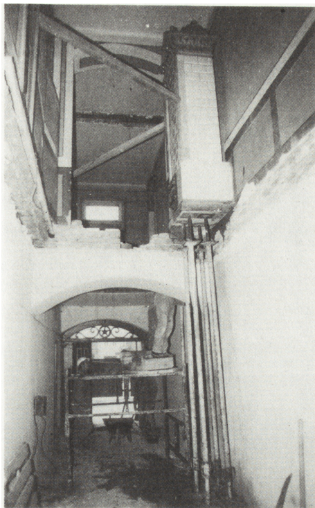
Ryc. 6. Remont kamienicy Przypkowskich. Wymiana stropów bez rozbiórki zabytkowych pieców
