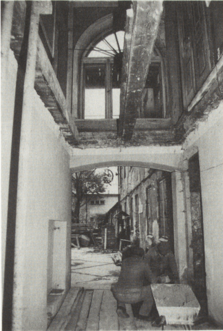
Ryc. 7. Remont kamienicy Przyppkowskich
