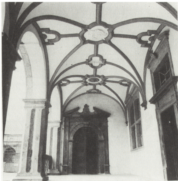
Ryc. 5. Sklepienie loggii wejściowej pałacu po konserwacji
