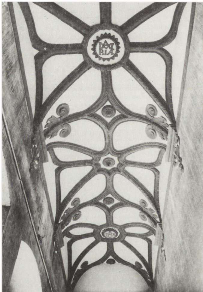
Ryc. 4. Sklepienie kaplicy pałacowej po konserwacji
