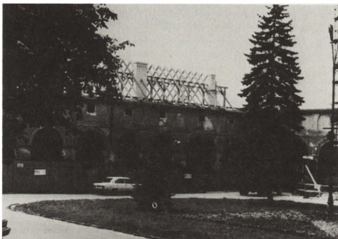
Ryc. 3. Skrzydło południowe pałacu kieleckiego podczas remontu — wymiana więźby dachowej związana z podniesieniem wysokości dachu (1985 r.)
