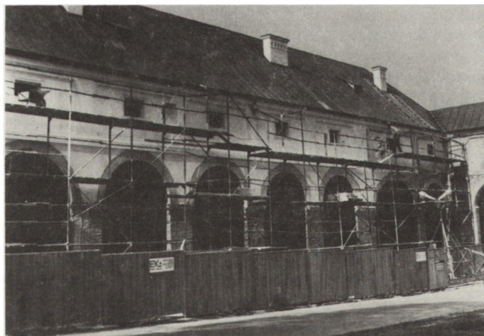
Ryc. 4. Skrzydło południowe pałacu kieleckiego podczas remontu — prace przy elewacji (1986 r.)
