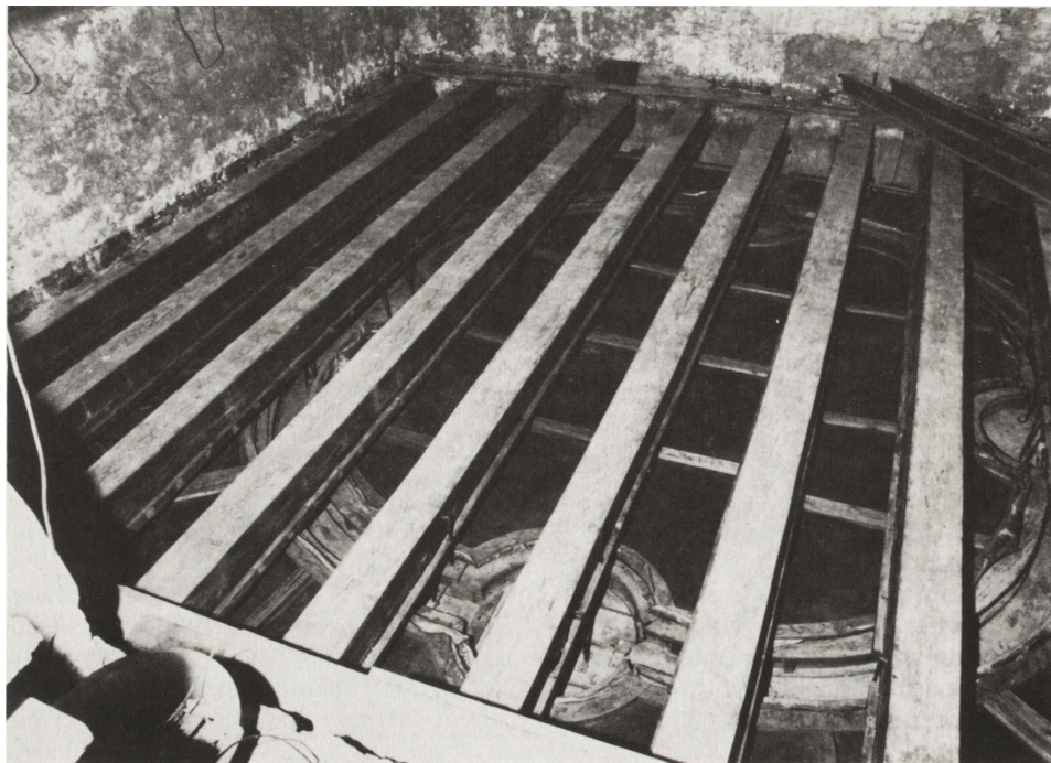
Ryc. 1. Strop ramowy w Trzcim Pokoju Biskupim. Widok ze strychu, stan po demontażu powalę i ślepego pułapu; fot. 4.06.1990 r.
