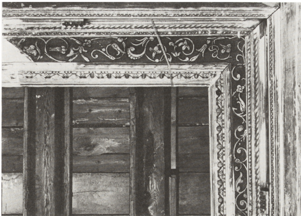
Ryc. 4. Strop ramowy w Trzecim Pokoju Biskupim. Narożnik południowo-zachodni. Zachowana oryginalna polichromia na poziomym gładkim pasie, oddzielającym ramę obrazu od gzymsu podstropowego
