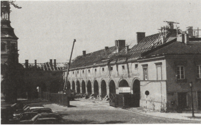
Ryc. 2. Pałac, skrzydło północne wraz z łącznikiem. Prace przy wiązaniu dachowym
