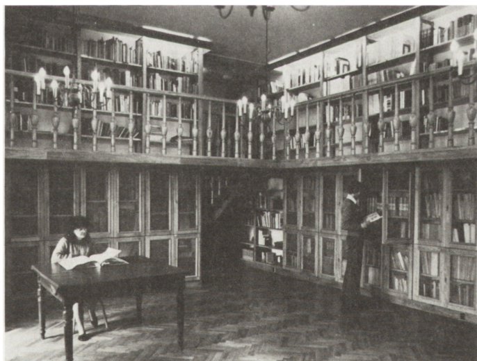
Ryc. 8. Budynek dawnej apteki, poddasze — wnętrze biblioteki
