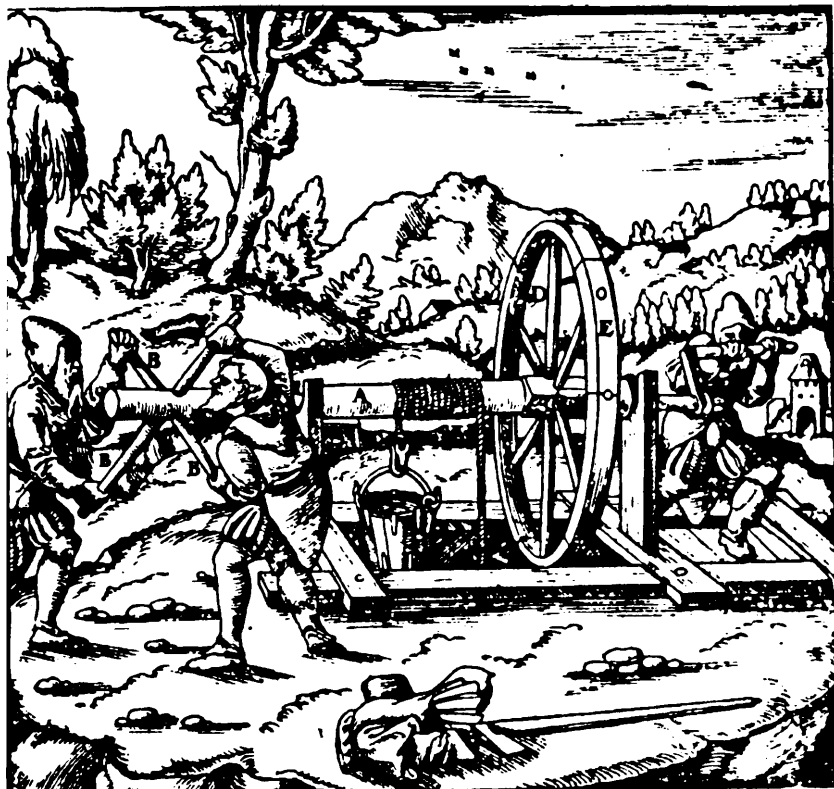
Ryc. 2. Kołowrót służący do wyciągania rudy lub wody podziemnej w czasach Odrodzenia (według Agricoli), repr. za K. Koźmiński Zagłębie Staropolskie . Warszawa 1955, ryc. na s. 74
