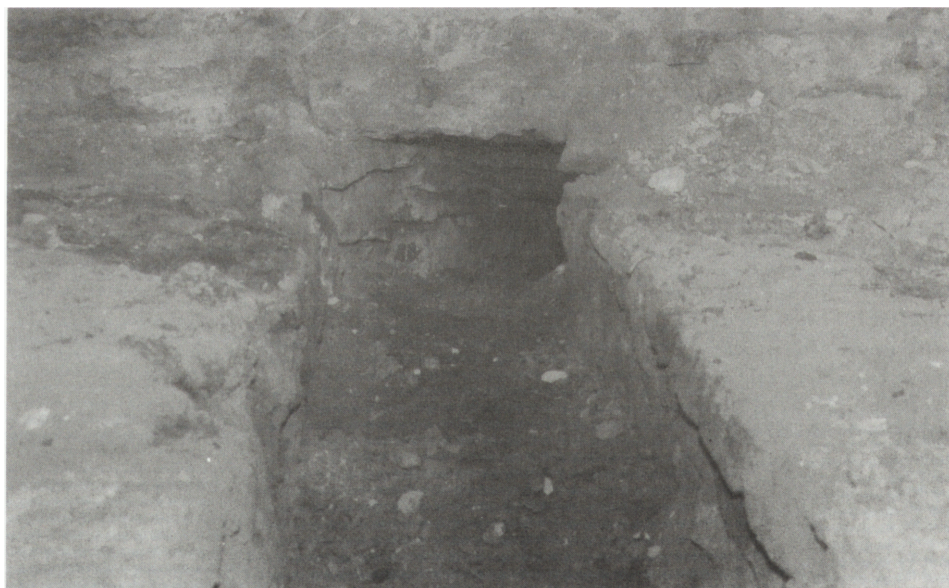
Ryc. 7. Laboratorium Akademii Górniczej – widok posadzki i kanału odpływowego odkrytych w trakcie remontu skrzydła północnego pałacu w 1991 r.
