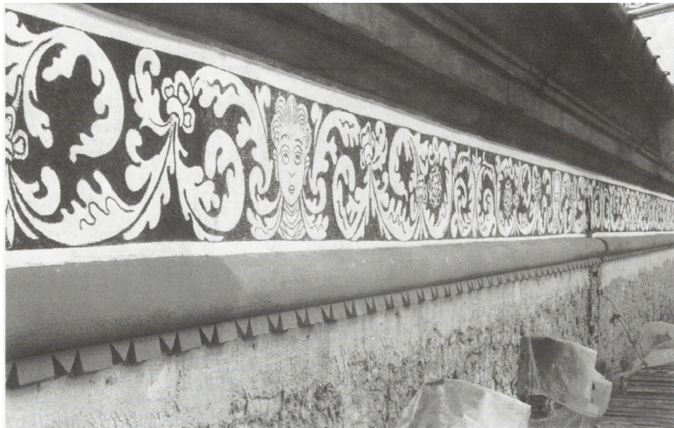
Ryc. 2. Elewacja ogrodowa pałacu w Kielcach. Fragment belkowania po konserwacji. Z lewej strony widoczny styk zrekonstruowanego odcinka fryzu z partiami zachowanymi
