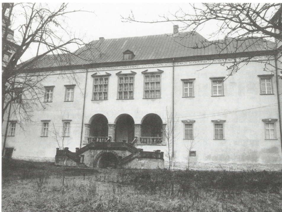
Ryc. 4. Elewacja ogrodowa pałacu w Kielcach. Stan po zakończeniu prac konserwatorskich przy sgrafficie i obramieniach okien oraz wymianie tynków
