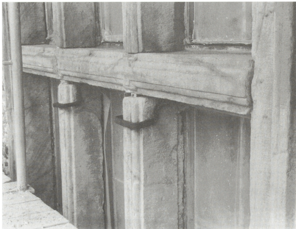
Ryc. 3. Elewacja ogrodowa pałacu w Kielcach. Fragment wielkiego okna z prawej strony. Stan po oczyszczeniu i usunięciu żelaznych płaskowników
