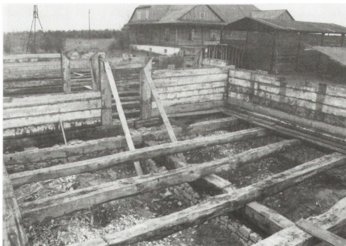
Ryc. 3. Prace montażowe przy spichlerzu ze Złotej Pińczowskiej (1773 r.)
