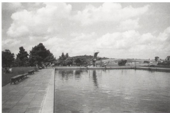
Il. 35. Stadion. Narożnik basenu z trampoliną.
