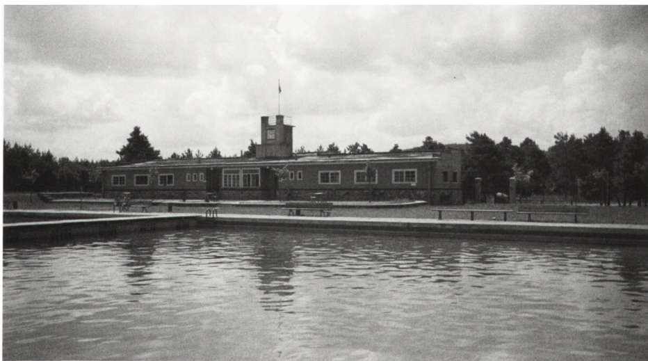
Il. 37. Stadion. Drewniany budynek przy pływalni.
