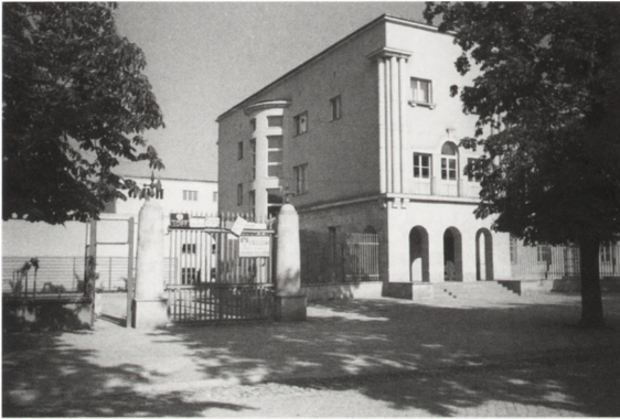
Il. 31. Dom WFiPW. Elewacja boczna.
