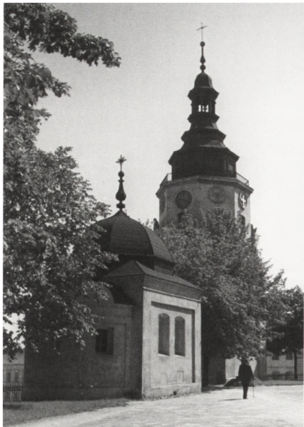
Il. 12. Plac katedralny. Budynek Ogrójca.
