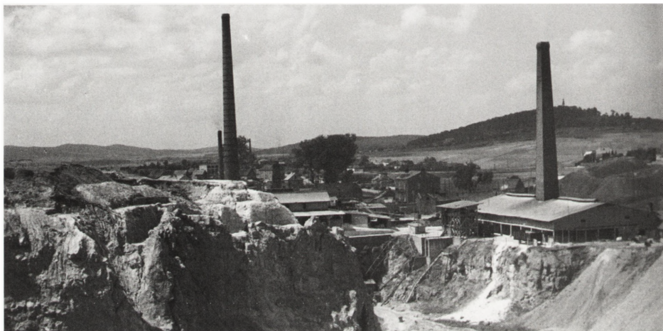
Il. 40. Kadzielnia. Kominy Zakładów Wapienniczych.
