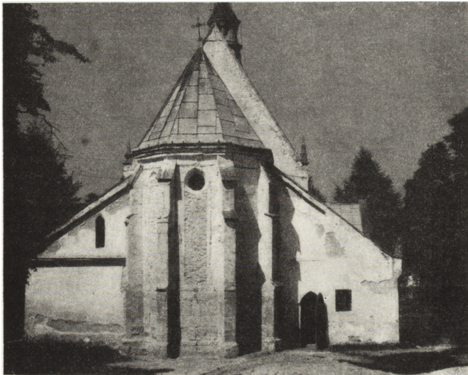
Zagość — kościół św. Jana Chrzciciela. Odsłonięcie spod tynków wątków gotyckich na prezbiterium.
