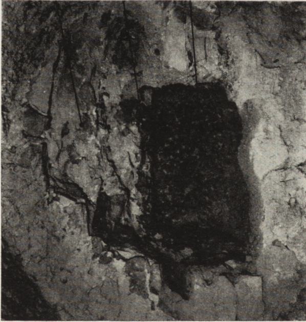
przekucie w murze wschodnim krypty
