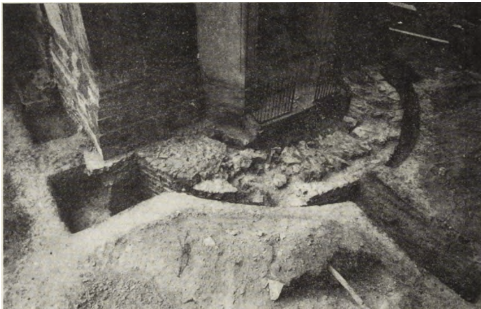
Ogólny widok wykopu badawczego
