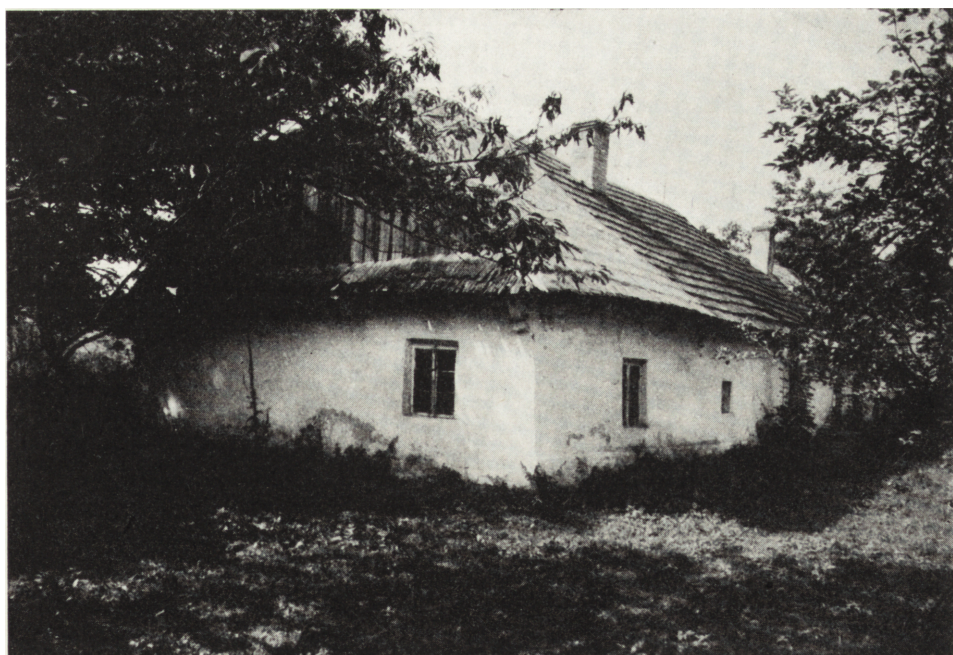
Ryc. 12. Widok domu pisarza browarnego od północnego wschodu
