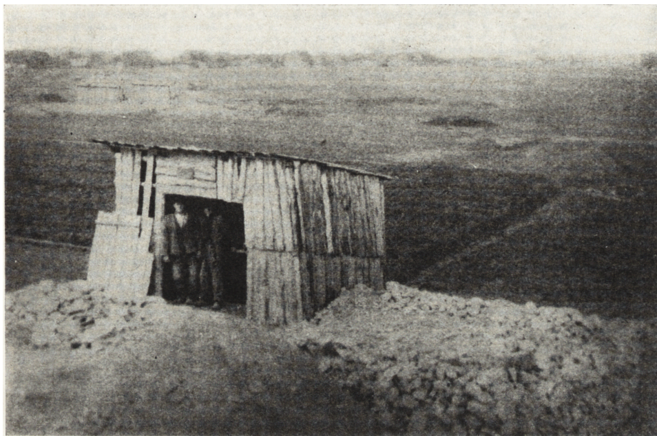
Ryc. 5. Szybikowa eksploatacja barytu w Strawczynku uruchomiona po ostatniej wojnie przez kielecką spółdzielnię „Kopaliny Mineralne”
