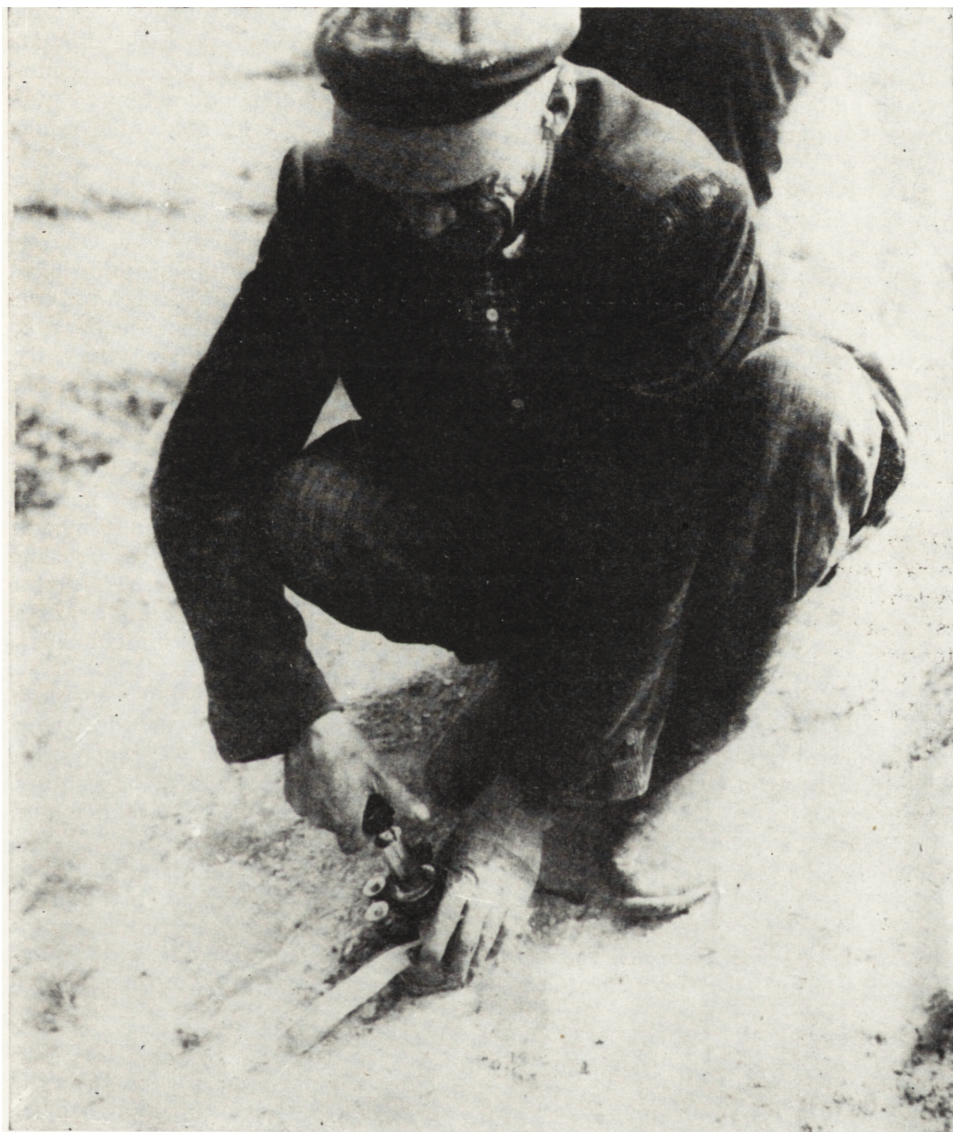
Ryc. 18. Elektryczne odpalenie ładunków materiału wybuchowego w szybie w Hucisku, dokonywane przez kierownika kopalni i byłego kierownika eksploatacji barytu w Strawczynku, Jana Nawarę, nestora, który od r. 1912 kontynuował w Strawczynku wydobywanie pod ziemią, współpracował z wszystkimi kolejnymi inwestorami złoża, a ponadto prowadził dla J. Czarnockiego poszukiwania za barytem w rejonie Góry Zachetnej. Przy redagowaniu niniejszej pracy żyjący jeszcze górnik udzielał swych cennych informacji.
