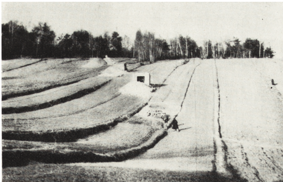
Ryc. 15. Szybiki eksploatacyjne, ustawione szeregiem na żył barytu w Hucisku
